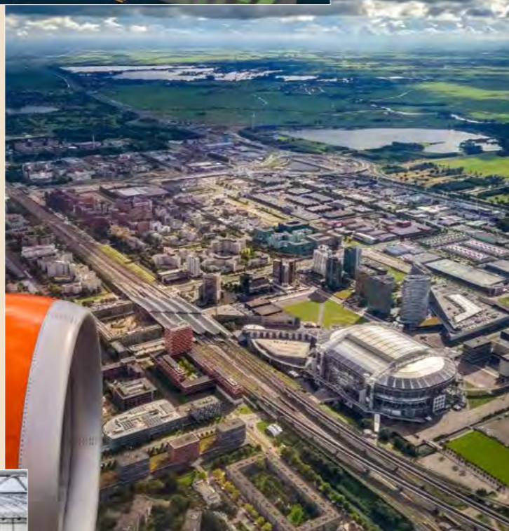
De stroom die wordt opgewekt door de zonnepanelen op het dak van de Johan Cruijff Arena in Amsterdam Zuidoost (b) wordt opgeslagen in de accu-installatie in de kelder van het stadion. Links op de foto de montage van de panelen op het dak van de Arena.
